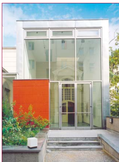
Blick vom Hof auf das Eingangsfoyer
